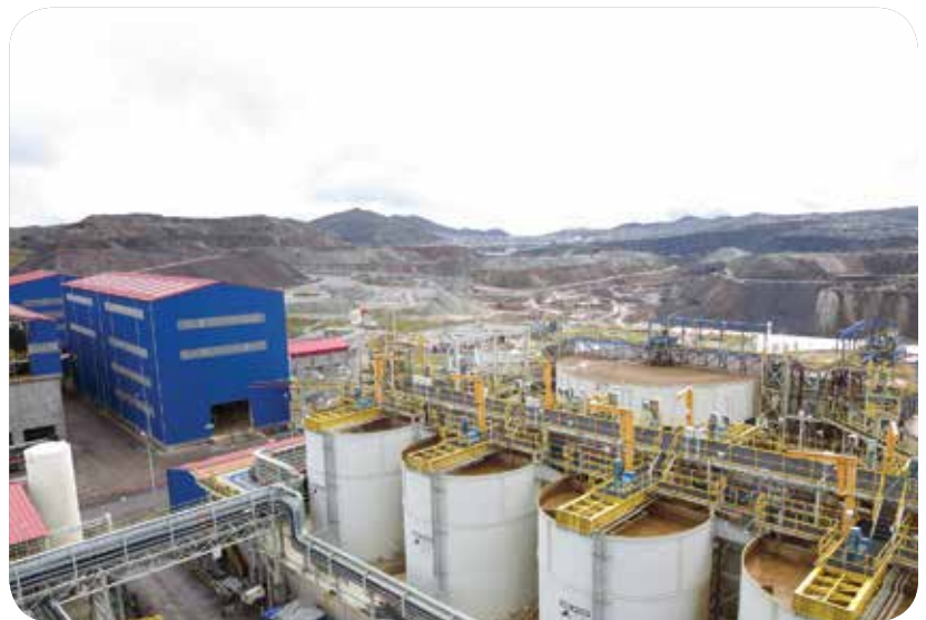
Vista general de los tanques de lixiviación y CCDs.
